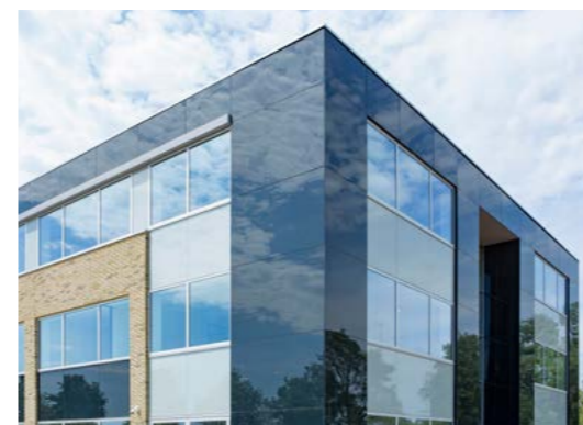
De gevel is geheel afgewerkt met panelen van volvlak geëmailleerd glas van het merk Colorbel. Die geven het gebouw een speels uiterlijk.
